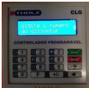
NO IHM, DISJUNTOR O NÚMERO DO DISJUNTOR OU CONTATOR A SER MANOBRADO.
